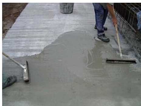
Aplicación de VANDEX SUPER en las losas de cimentación
