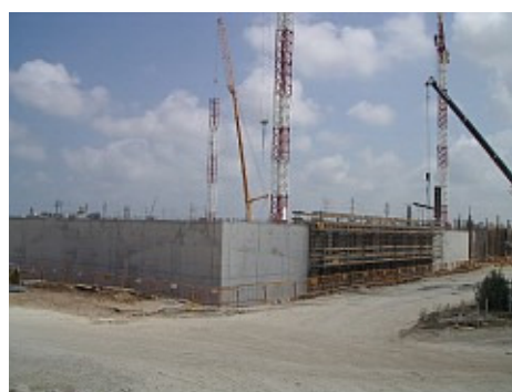
Muros de hormigón de la planta baja
