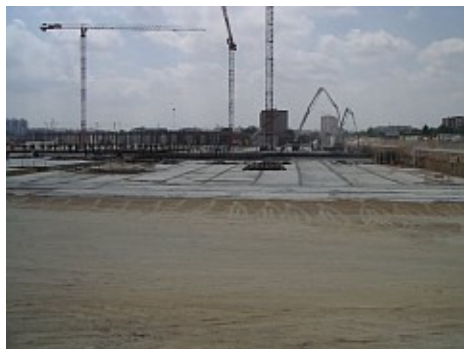
Vista general de la obra en construcción
