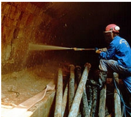
Preparación de la superficie mediante chorreo de agua a presión
