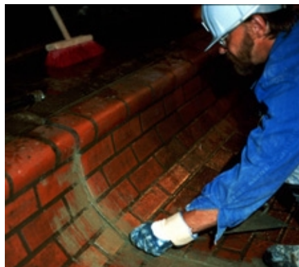
Relleno de juntas de elementos prefabricados con VANDEX UNI MORTAR 1 Z
