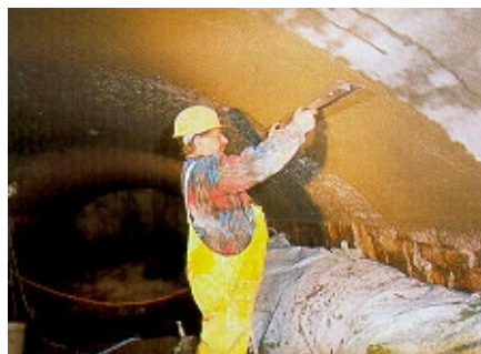
VANDEX UNI MORTAR 1 Z aplicado en spray sobre la superficie
